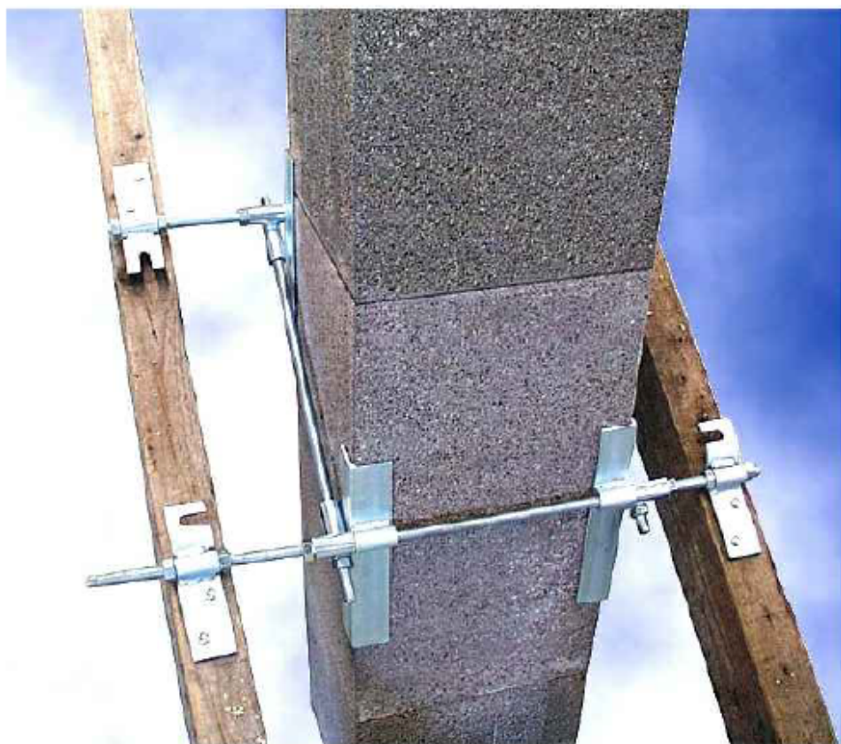
Узел устройства крепления к стропилам.
